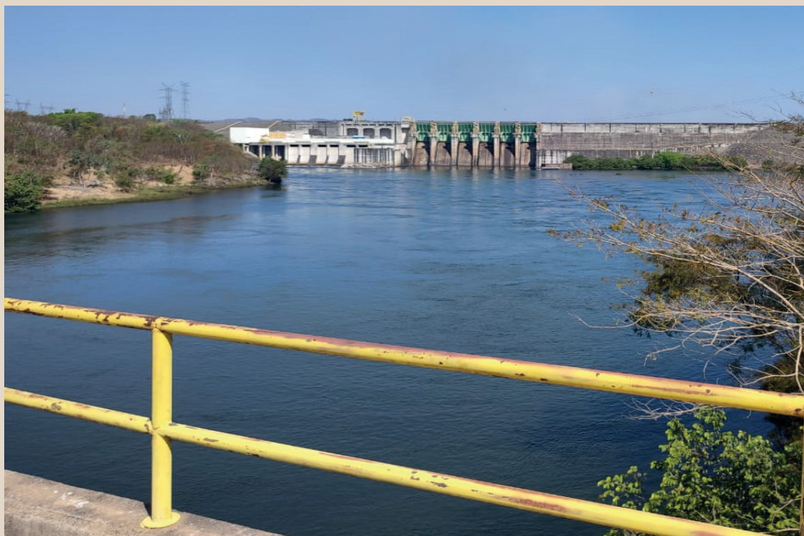
Barragem da Usina de Cana Brava - Minaçu-GO (Foto: Comitiva da Entraide & Fraternité)
